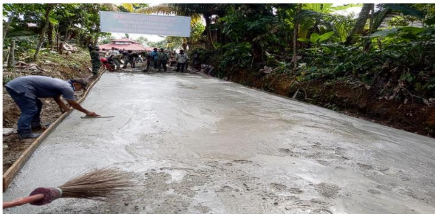
Gambar 2 Penghamparan Beton di Lokasi Jalan
