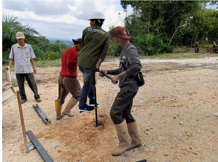
Gambar 5. Pelaksanaan kegiatan pengabdian. (a) Mahasiswa teknik sipil Universitas Pahlawan (b) Pemasangan jangkar sondir.
